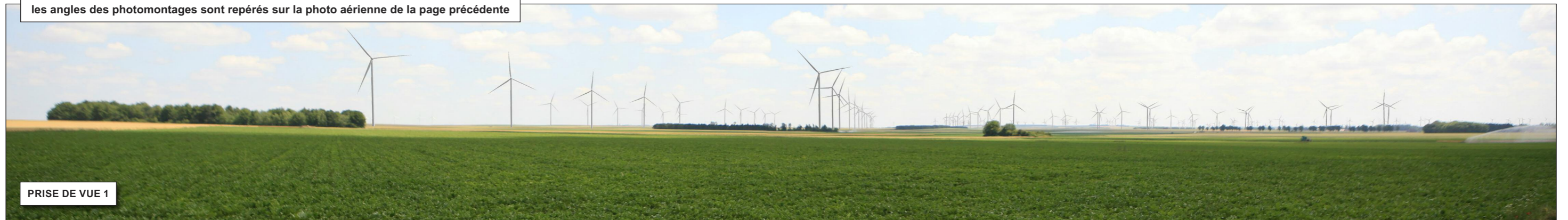
VUE PANORAMIQUE DU PROJET ÉOLIEN DEPUIS LA RD53, ENTRE LES VILLAGES DE PLEURS ET COURCELLES
