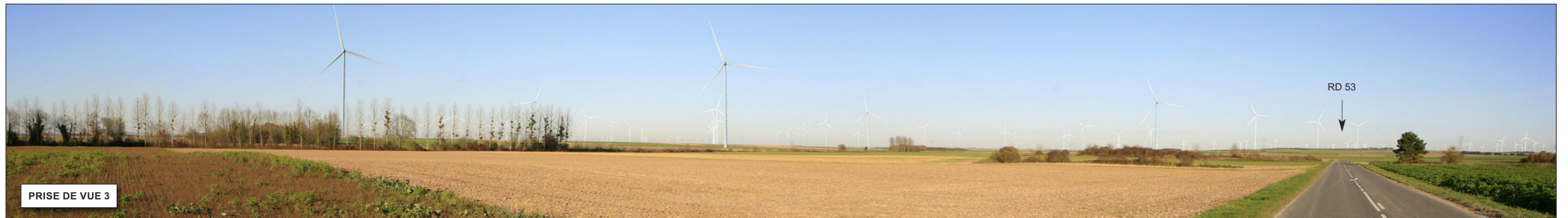
VUE PANORAMIQUE DU PROJET ÉOLIEN DEPUIS LA RD53, À LA SORTIE EST DU VILLAGE DE FAUX
